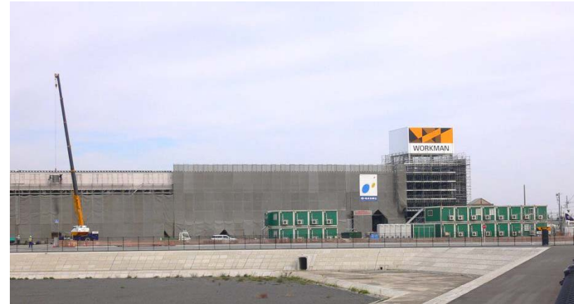
新流通センター建設現場の様子
